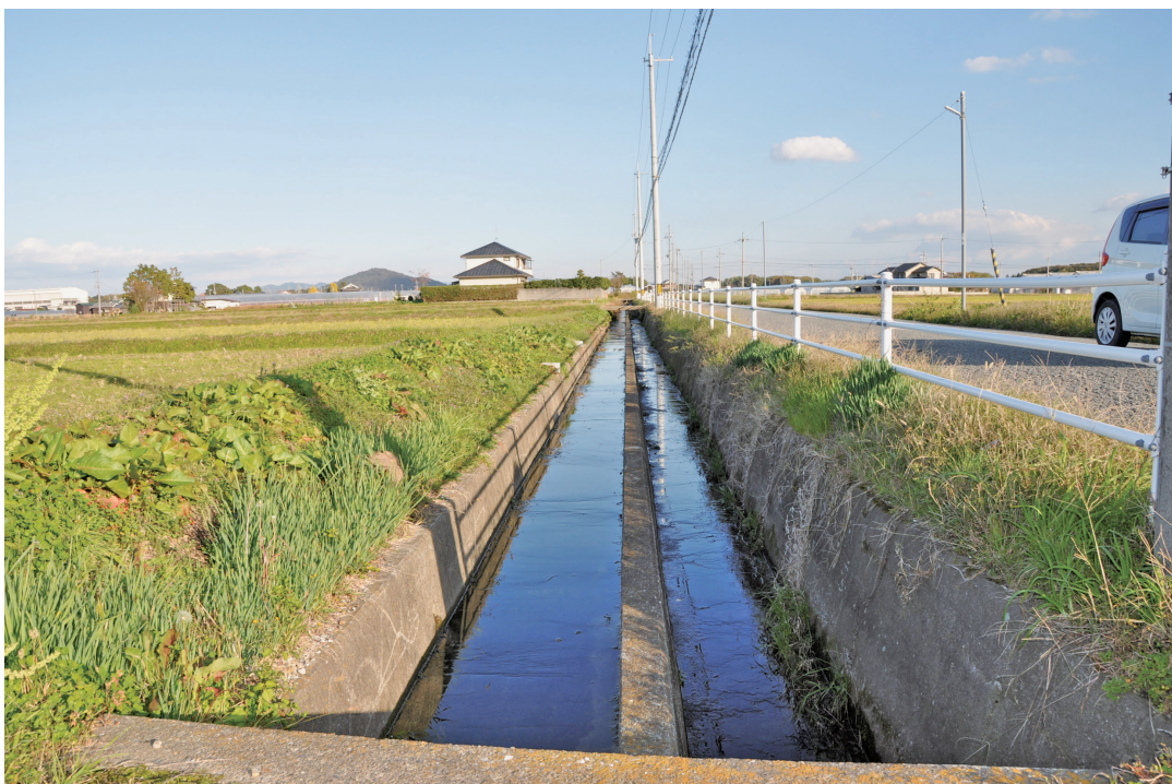
道路沿いを走る開水路（加古郡稲美町野谷 のだに ） 左の水路は南池小支線水路 みなみいけ
