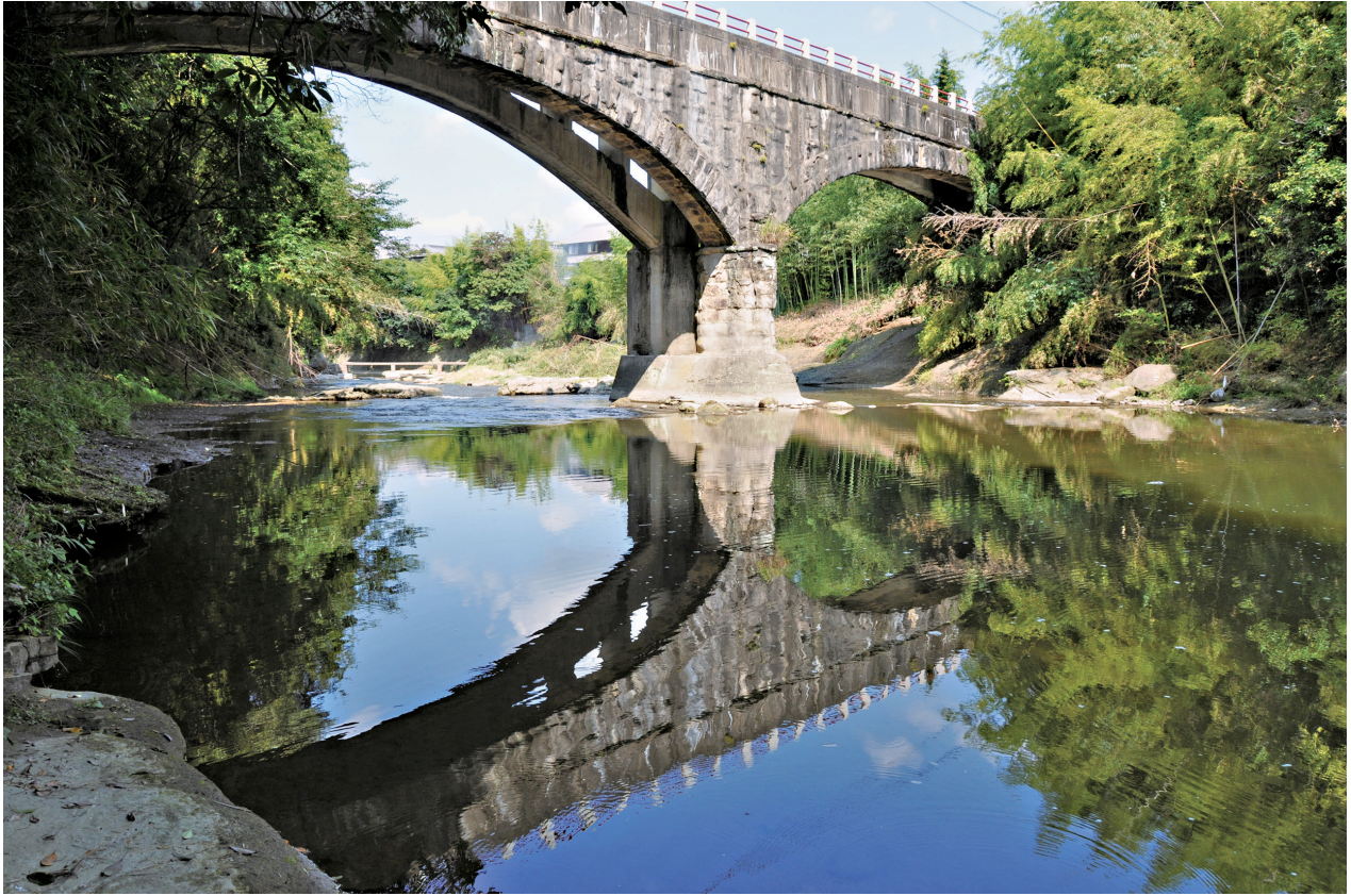
しじみがわ 志染川上流から見た眼鏡橋 (アーチの上部をサイフォン管が通過：右上流)
