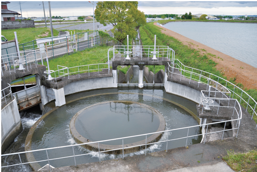
おいのくち かんでちょうひがし 老ノ口分水所から下流に延びる合流幹線水路（神戸市西区神出町東）
