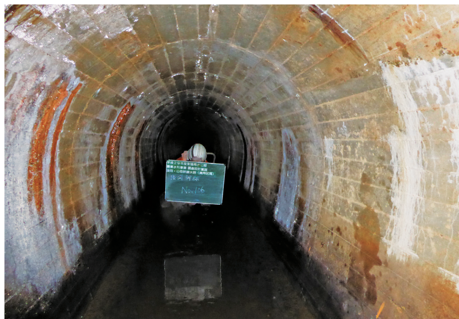
トンネル内部を覆うコンクリート (三木市志染町青山)
