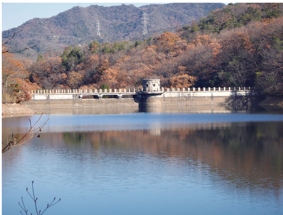
上流からの全景
