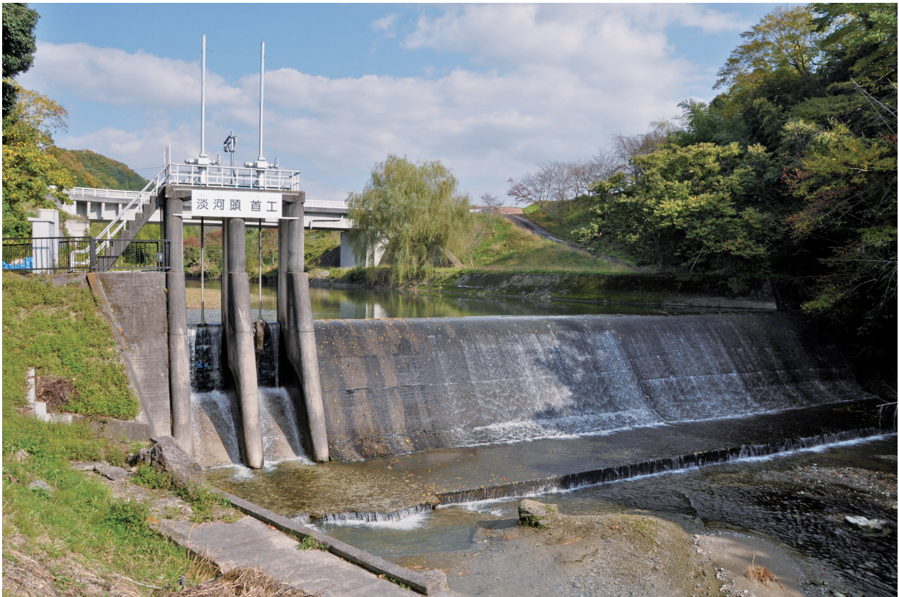
下流側から見た堰体と土砂吐ゲート せきたい どしゃばき
