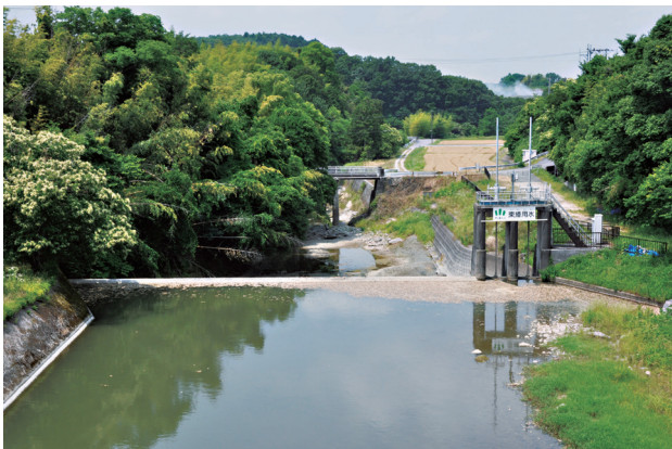
上流からの全景
