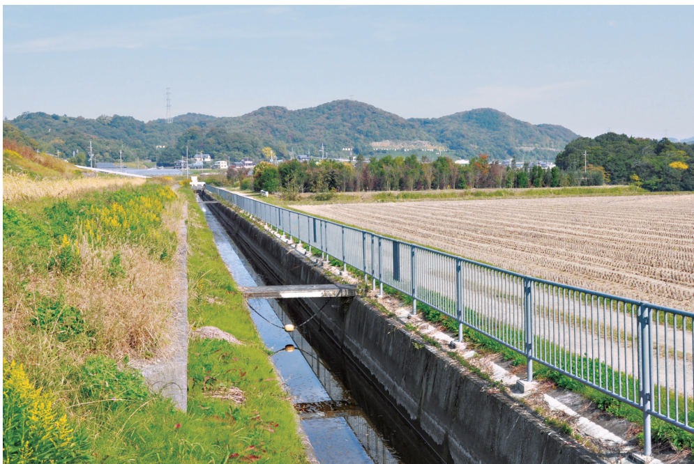
高台のほ場整備地内を一直線に走る幹線水路（手前下流）
