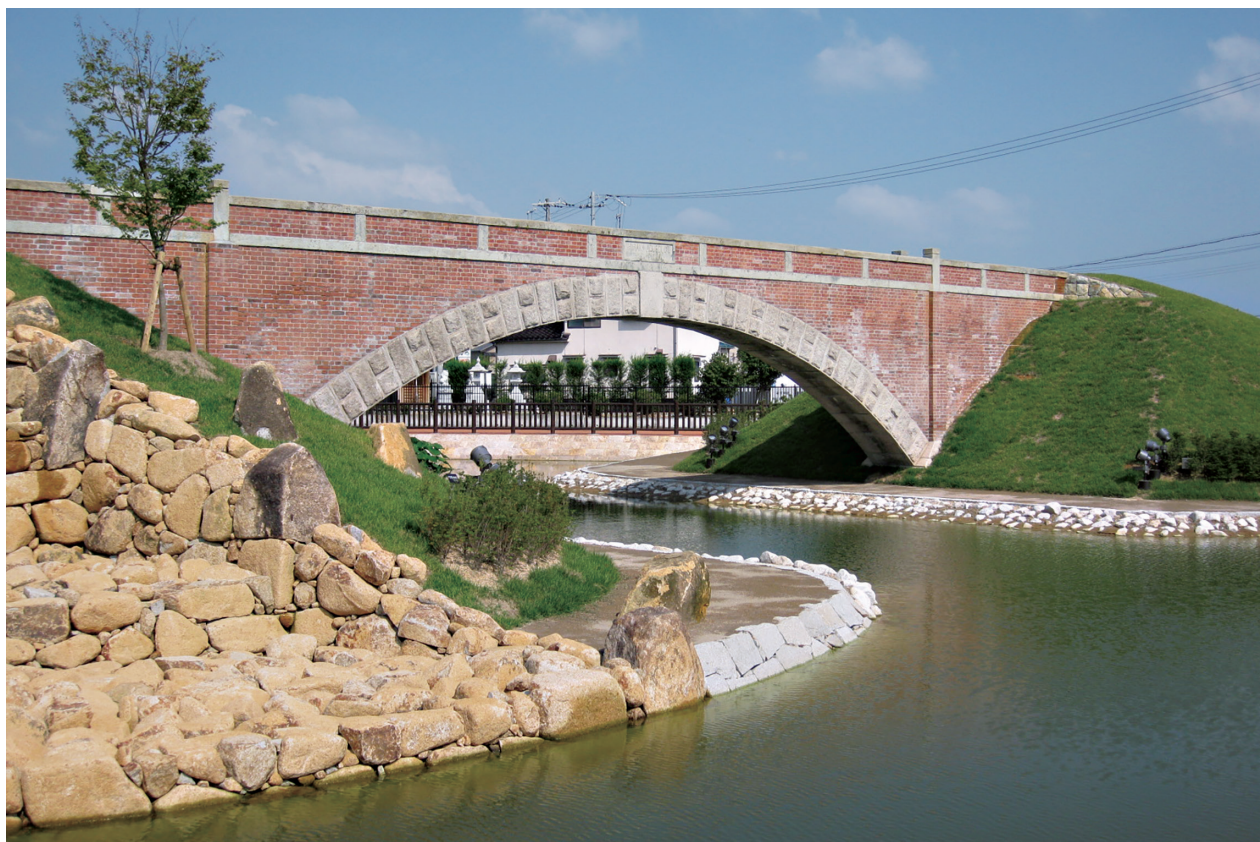
まえのいけ 前の池に移築された平木橋
