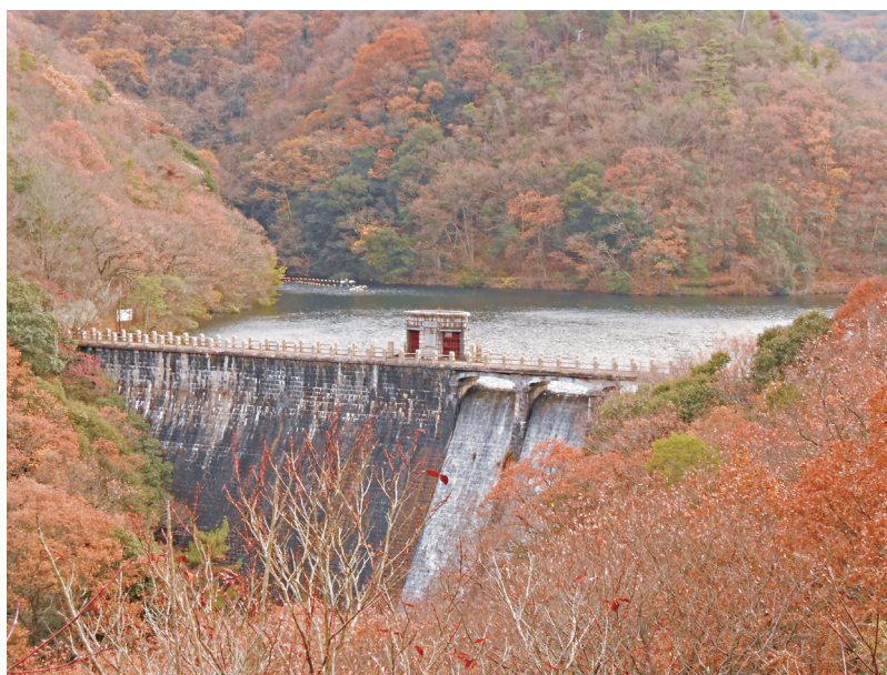
下流からの全景
