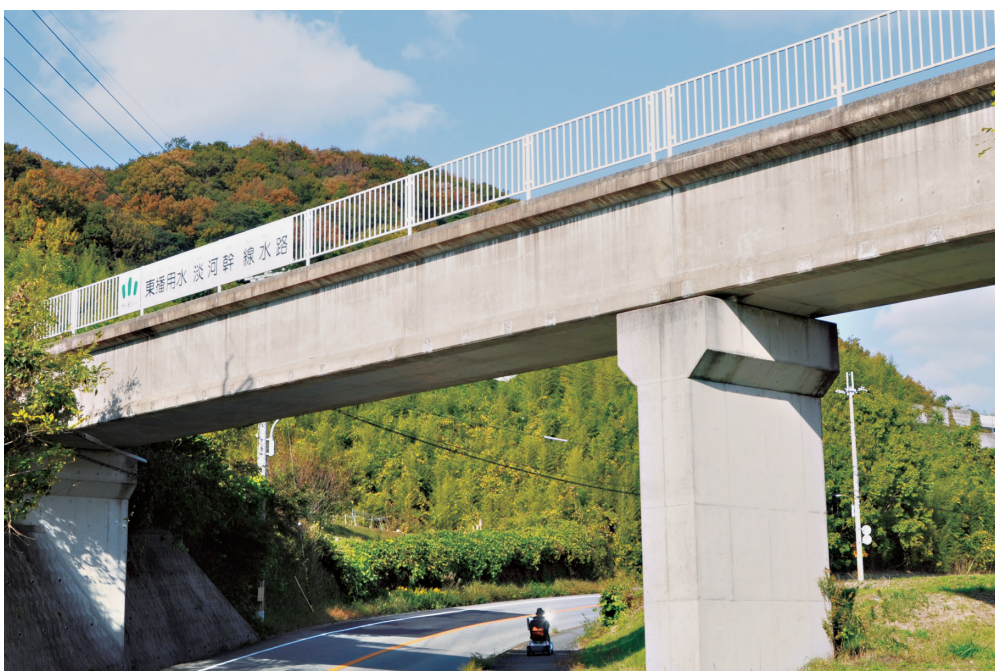
国道 428 号線を渡る水路橋（右上流）
