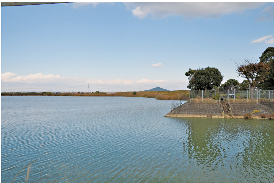
堤防から上流側（神戸市西区 いわおかしやう 岩岡町 い 岩岡）
