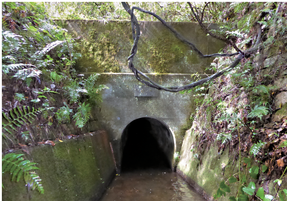
トンネル上流入口 (三木市志染町窟屋)
