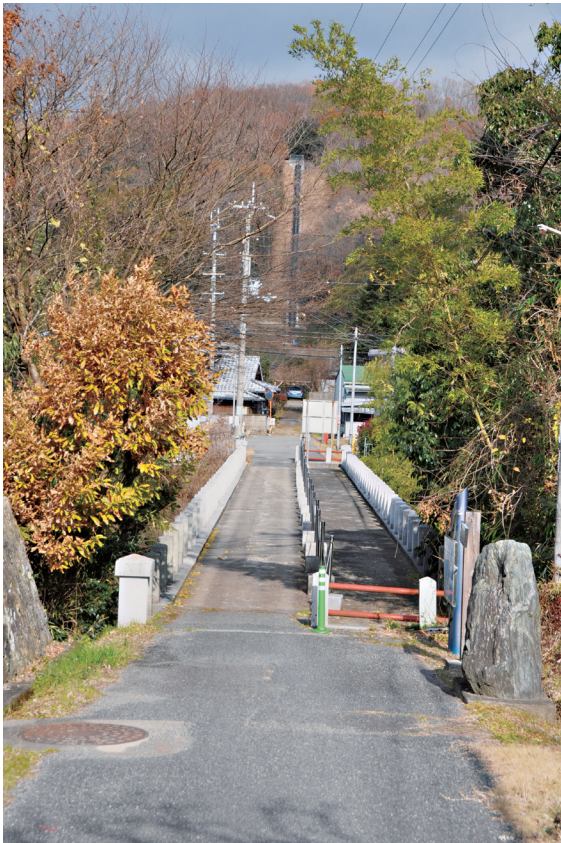
めがねぼし 眼鏡橋上部と斜面を下るサイフォン管上流側 (手前下流)
