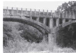
御坂サイフォン橋（下流側）
