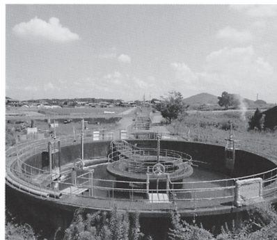
練部屋円筒分水工(神戸市西区神出町)
