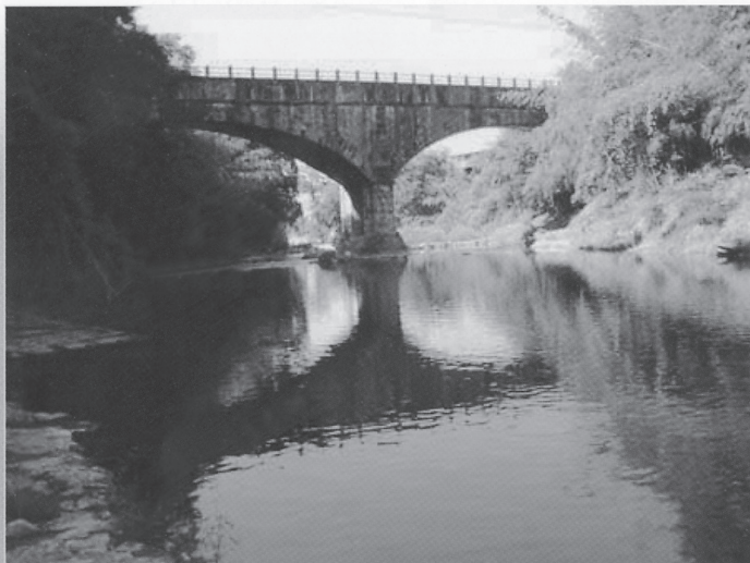
御坂サイフォン橋(上流側)。明治24年完成。全長約57m、高さ約12m。橋の内部をサイフォン管が通る。水面に映る姿から、「眼鏡橋」とも呼ばれる。淡河川疏水の主要施設で、上流側は創建当時の姿をとどめている。土木学会が技術的、デザイン的にすぐれたもの、ないしは由来やエピソードが豊富な構造物を毎年全国で10件程度、認定・表彰する「選奨土木遺産」に認定されている
