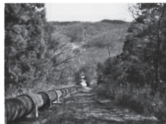
流出口側から見た現在の御坂サイフォン。対岸の丘から下る鉄管が、手前の丘に這い上がっている。
