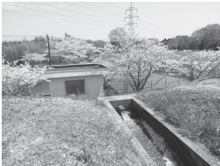
ポンプ池揚水所（岩岡揚水所 いわおか ）
