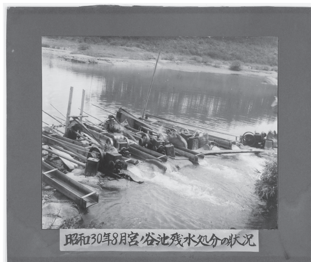
みやがだに しすい 宮ヶ谷池調整池死水ポンプアップ
