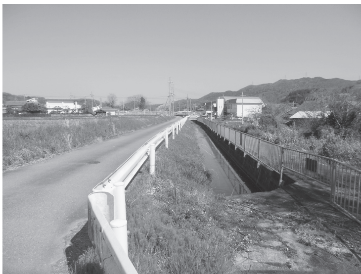
おうごちょうはぎわら 淡河町萩原を通る淡河川幹線水路
