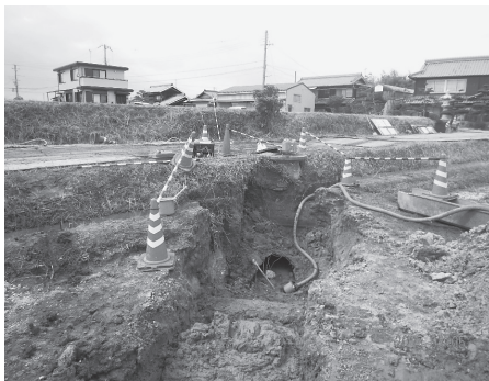
掘削撤去工 (新中 しんなか マンポ)
