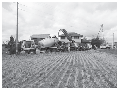
エアモルタル注入工 (立杭) (印南 いんなん マンポ)
