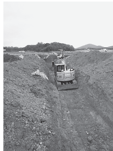
埋戻工 (合流幹線マンポ)
