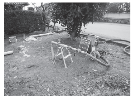
エアモルタル注入工 (ボーリング孔) (森安 もりやす マンポ)
