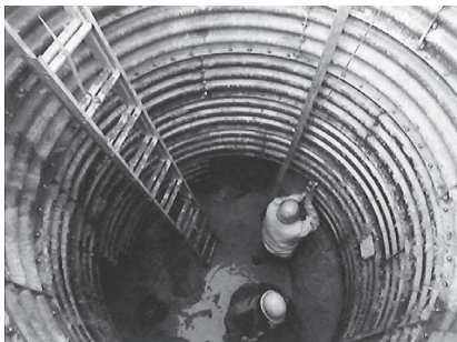
注入口立杭設置工 (印南 いんなん マンポ)
