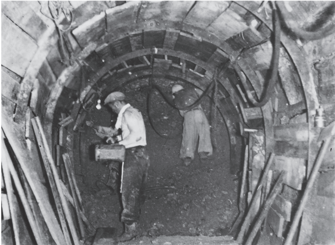
おうごわそすいけしやま しじみちょういや あおやま 澁河川疏水芥子山トンネル付替工事（三木市志染町窟屋・青山間）
