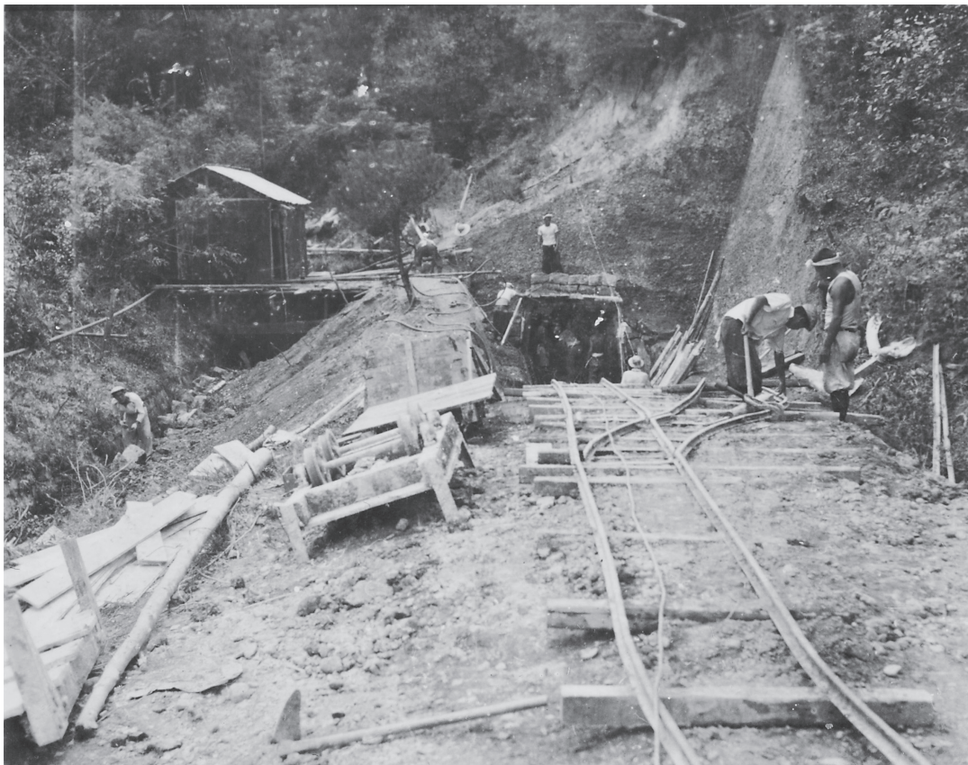
おうごわそすいながお みどりがおかちょう 澁河川疏水長尾トンネル付替工事（三木市緑が丘町）
