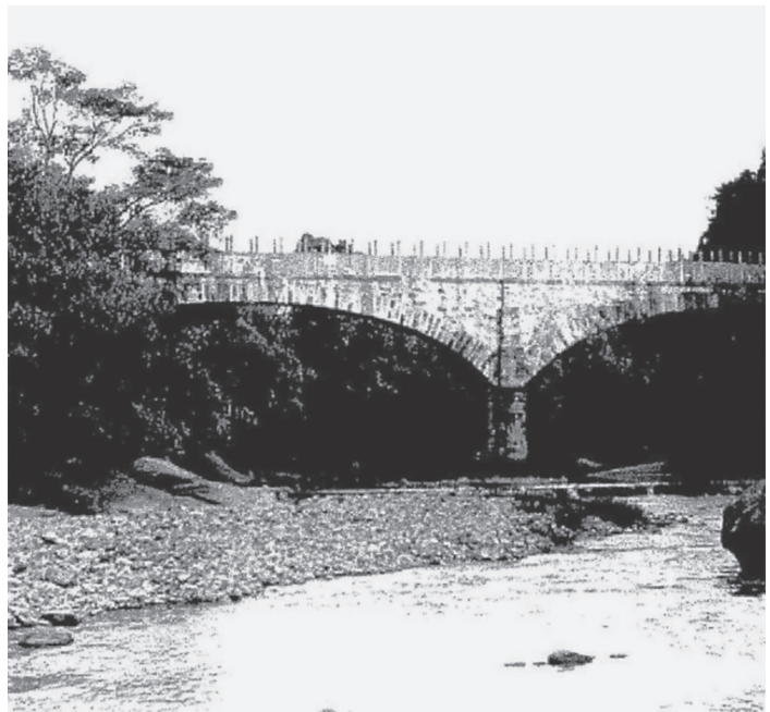
めがねばし 拡幅前の眼鏡橋 (下流から)
