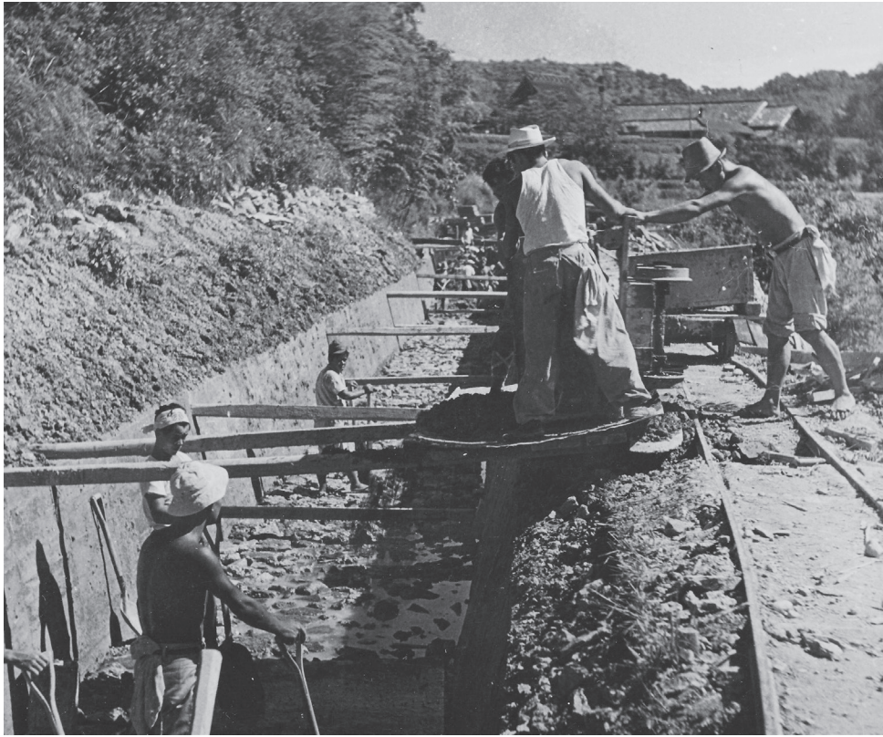
おごがわそすい 淡河川疏水幹線開水路工事 (神戸市北区淡河町萩原) おごちようほざわら
