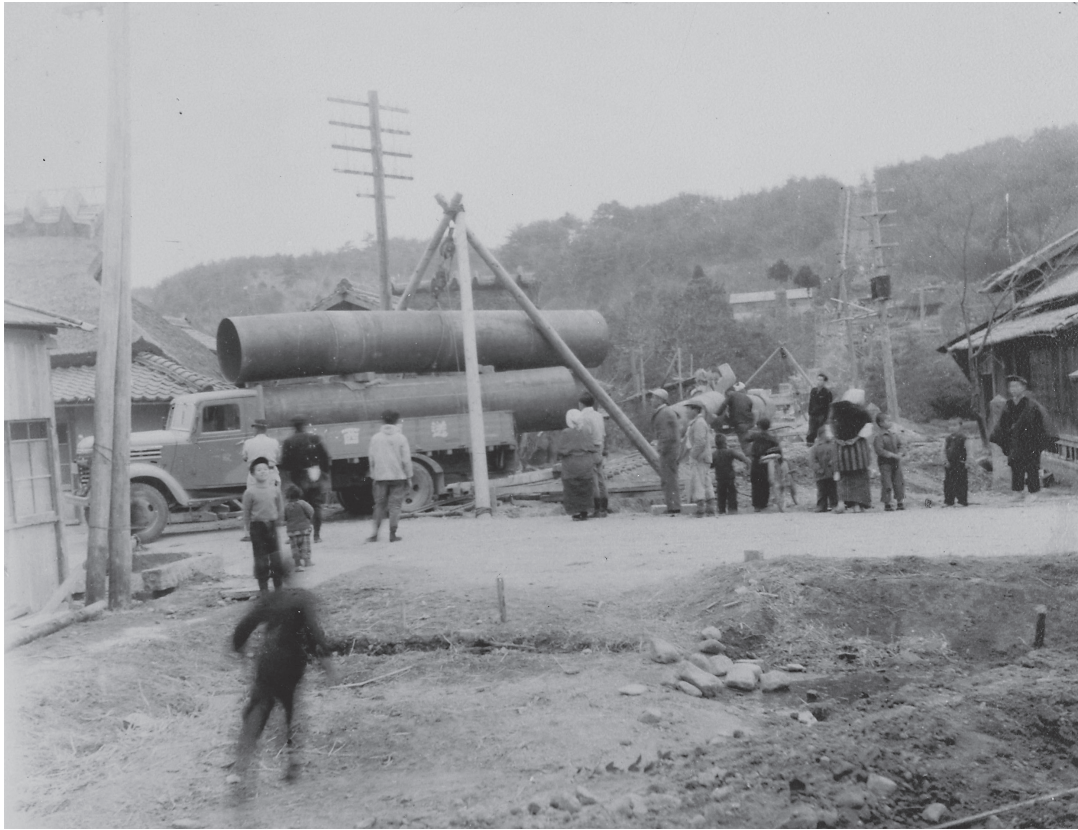
おうごがわそすいみさか しじみちようみさか 淡河川疏水御坂サイフォン管敷設工事1 (三木市志染町御坂)
