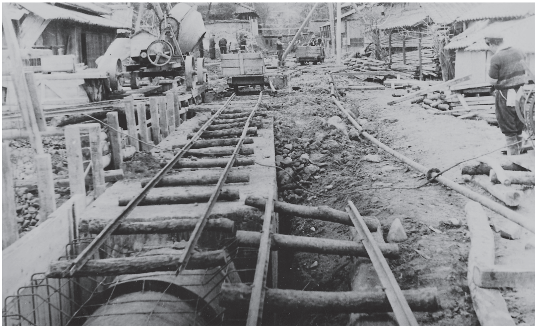
おうごがわそすいみさか しじみちようみさか 淡河川疏水御坂サイフォン管敷設工事2 (三木市志染町御坂)
