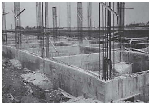
事務所建設基礎工事 2
