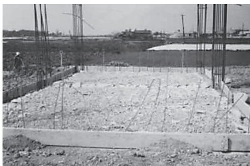
事務所建設基礎工事 1
