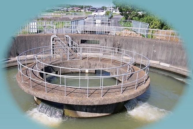
練部屋分水工
