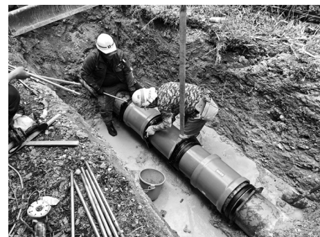
【水路漏水補修】
