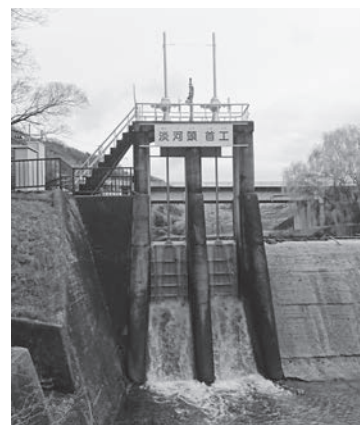
【R4実施：淡河頭首工ゲート整備】
