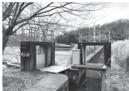
【R4実施：勝雄本線ゲート整備工事】
