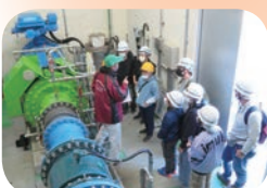
小水力発電所
