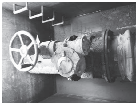
【R5実施予定：バタフライ弁整備】
