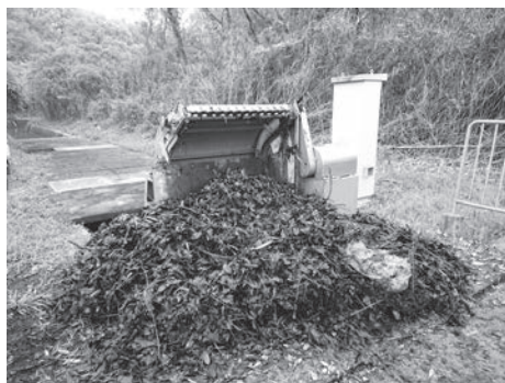
水路内の除塵作業
