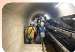
ダム堤体階段
