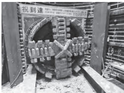
山田幹線水路（緑が丘サイフォン）シールド工事
