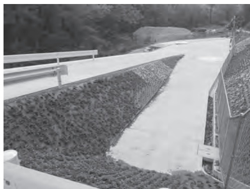
淡山連絡水路（山田幹線水路合流部）※芝桜開花時期
