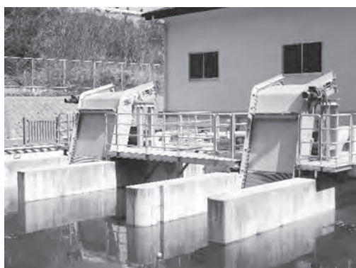
淡山連絡揚水機場（除塵機完成）
