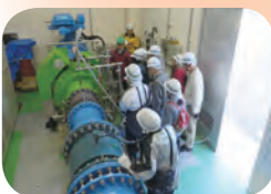
小水力発電所
