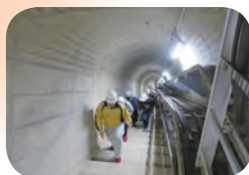
ダム堤体階段
