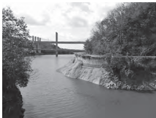
吞吐ダム満水面保護対策完了
