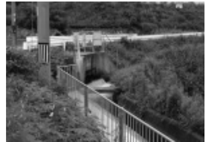
転落防止用フェンスの設置例
