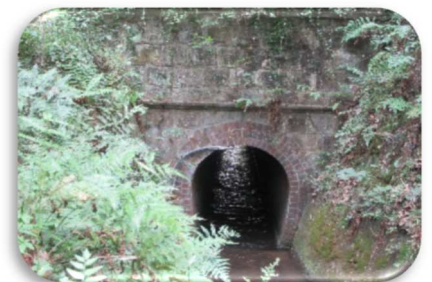
淡河幹線水路10号トンネル探検
